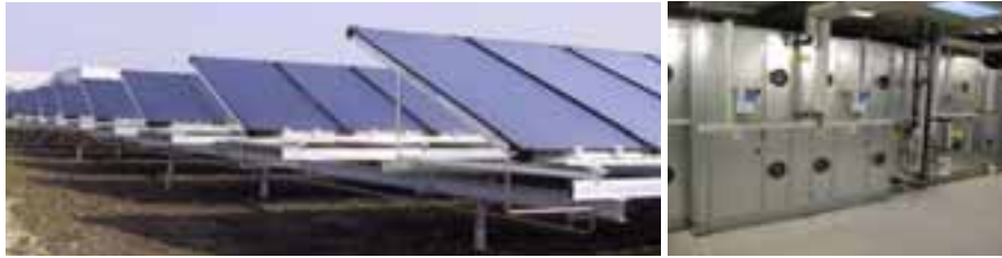
Fig. 1: Solar-driven DEC-system in Ingolstadt
