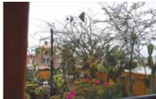
Actual state of green roof
